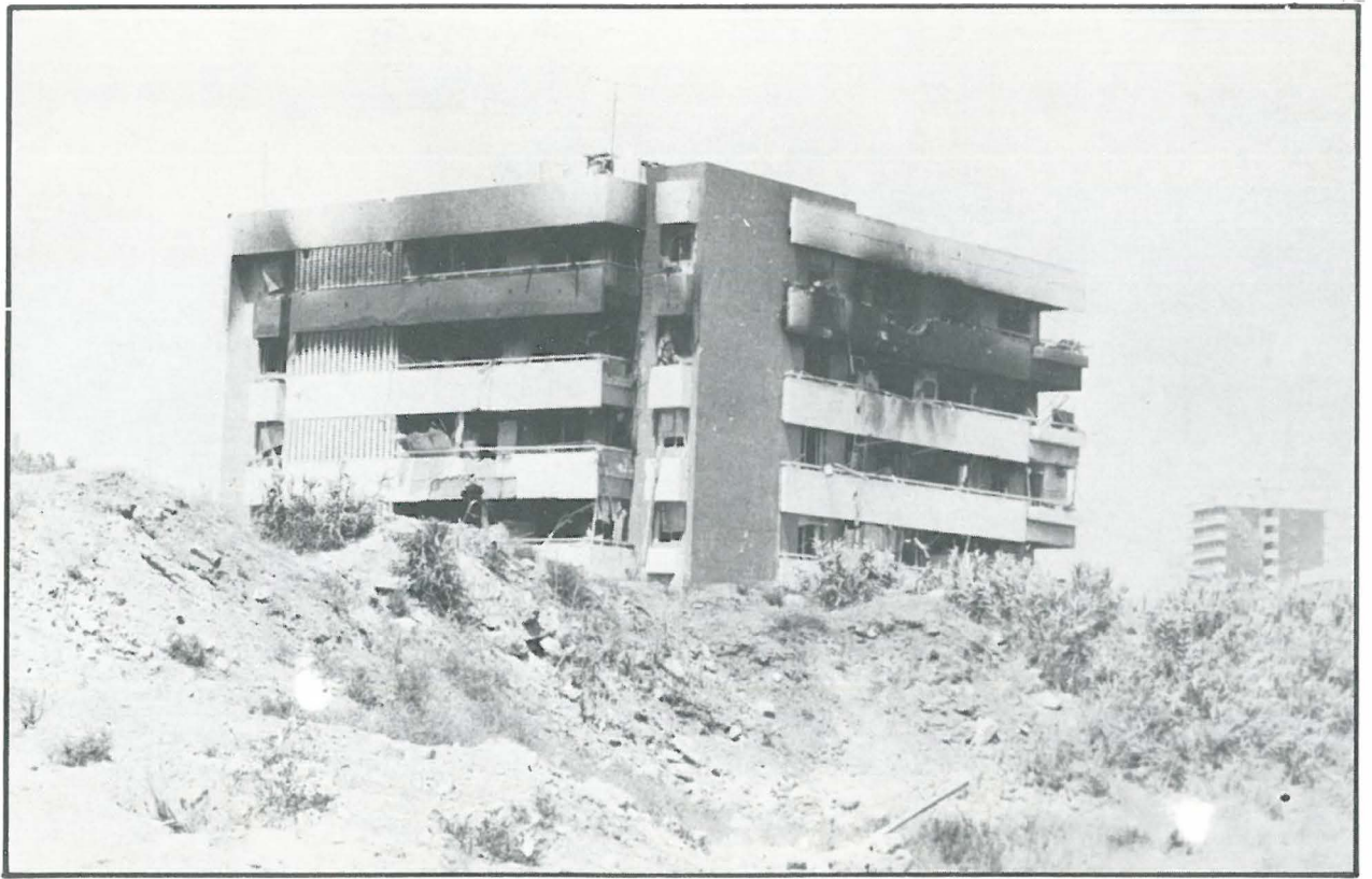
دمار وحرائق في مبنى بالرملة البيضاء
